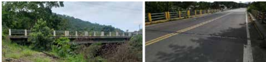
Figura 7. Vistas del puente sobre el río Mocora Fuente. Benavides y Díaz (2020)
