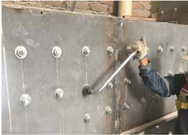
Figura 227. Control de ajuste de tuercas en encamisado metálico Fuente. (VICROADS, 2018)
