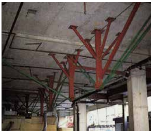
Figura 3. Tendones y apoyos metálicos bajo una losa de un parqueadero Fuente. Barchas (1991)
