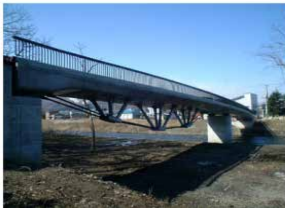
Figura 2. Vista inferior del postensado externo del puente Fégire en Suiza Fuente. Suntharavadiel y Aravinthan (2005)
